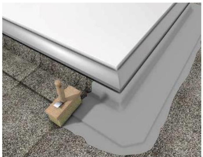
4 Герметизація стиків і протікань навколо люків, мансардних вікон тощо на поверхні дахів
