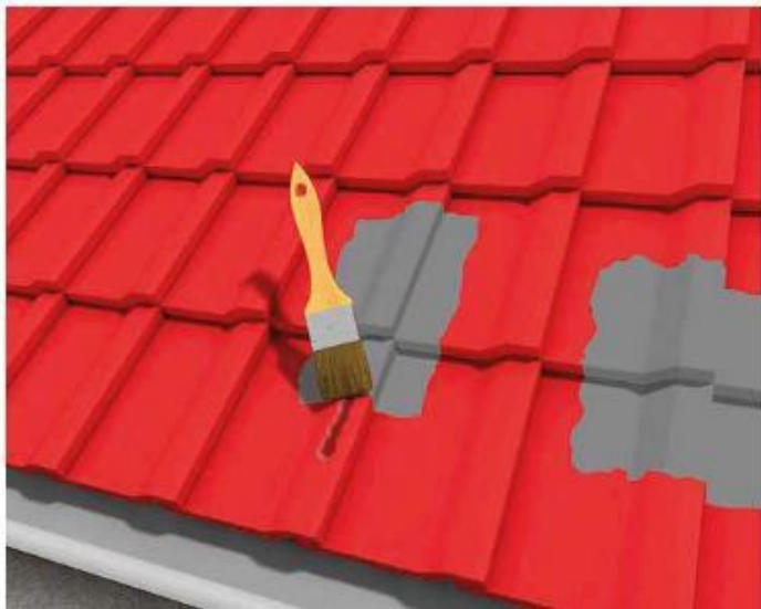
1 Герметизація покрівельних покриттів (включаючи черепицю)
