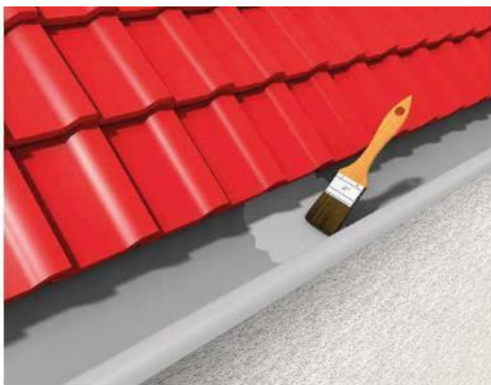
3 Герметизація водостоків
