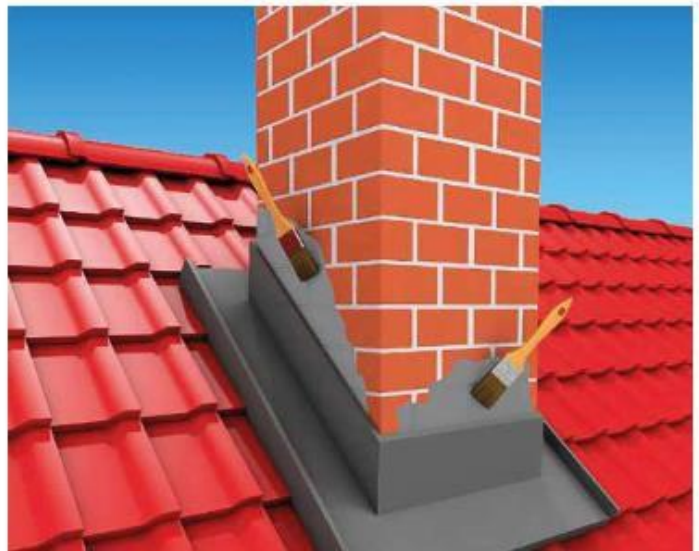
2 Усунення протікання на димохідних патрубках
