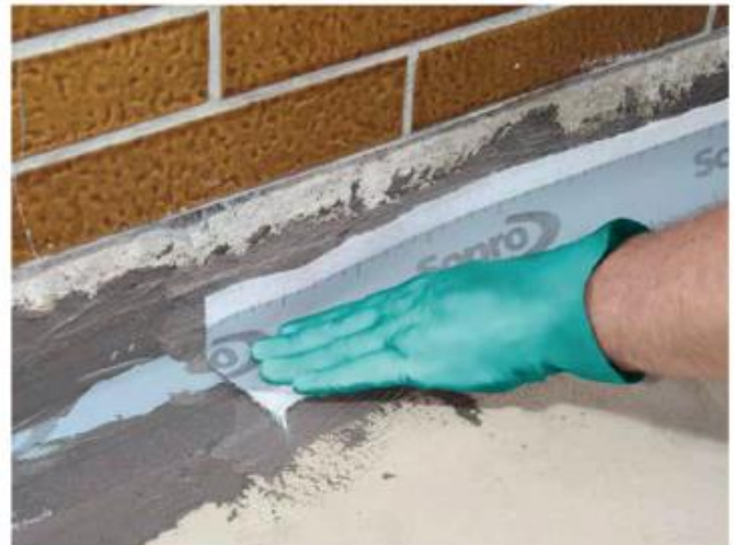
8 ... ущільнювальної стрічки Sopro DBF 638. Додатково притисніть стрічку до основи.
