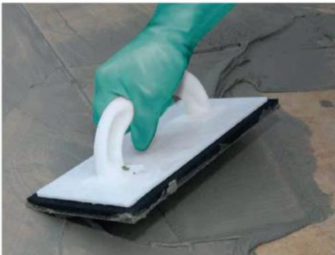
21 Після того, як високоеластичний клейовий розчин Sopro затвердіє, вирівняйте облицювання затіркою Sopro (наприклад, Sopro DF 10® або Sopro FL plus).
