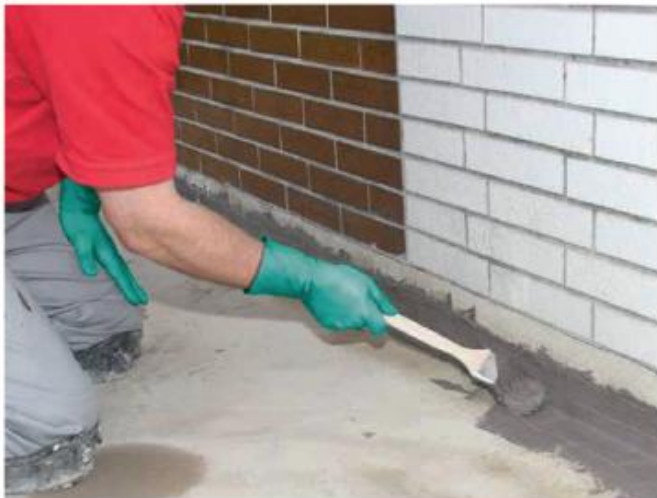
7 В області цоколя за допомогою пензля нанесіть суміш Sopro TDS 823 для закладення ...
