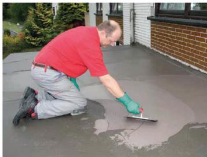
14 Нанесення другого шару герметика відбувається всього через 2 години на висохлий перший шар ...
