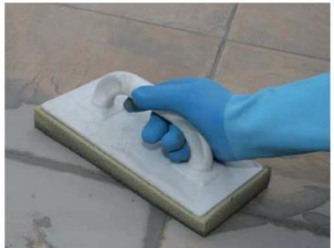
22 Після того, як затирка Sopro трохи схопиться (затирка застигне в швах), вимийте облицювання, що затірилося, дочиста.
