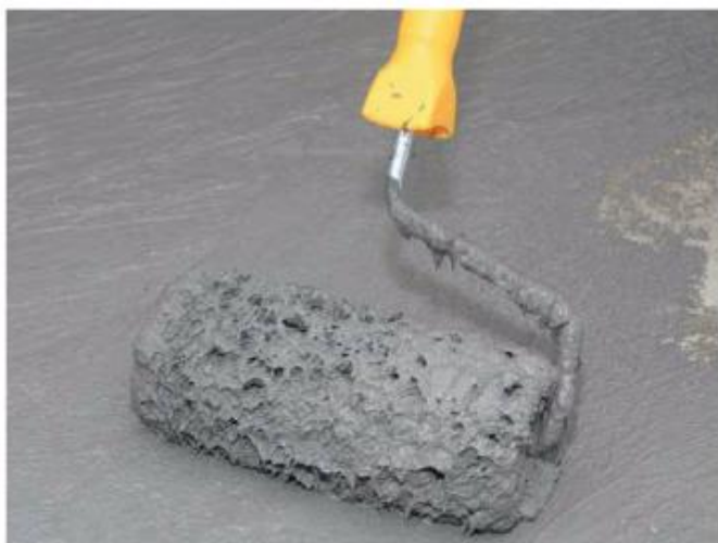
13 Герметик Sopro TDS 823 також можна наносити за допомогою малярного валика.
