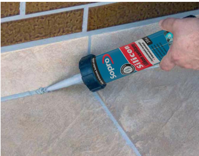
23 Заповнити деформаційні шви та кутові з'єднання санітарним силіконом Sopro.
