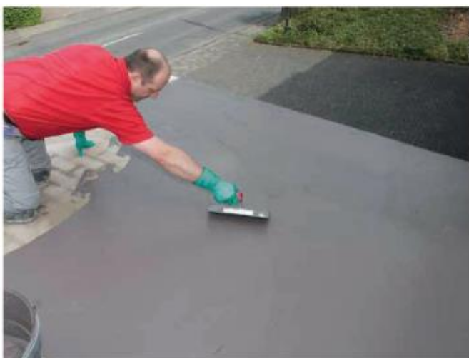
11 Розгладьте поверхню гладкою частиною зубчастого шпателя.
