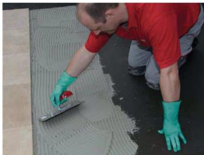
16 На висохлий герметик нанесіть високоеластичну двокомпонентну клейову суміш S2 Sopro MEG 667.
