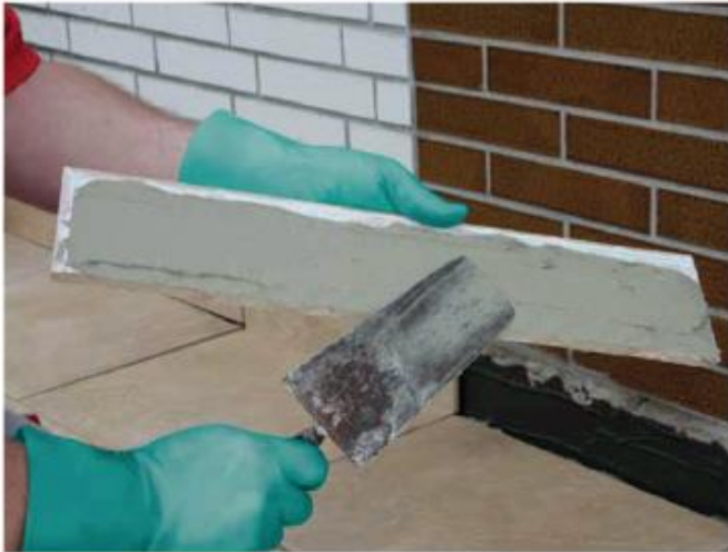
19 Нанесіть еластичний розчин Sopro (наприклад, Sopro No. 1 400 extra, Sopro FKM XL 444) на нижню сторону правильно обрізаної плитки плінтуса.....
