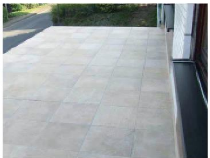
24 Нещодавно укладена обшивка на балконі з використанням системи Sopro.
