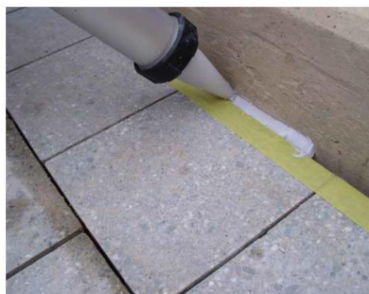
3 За допомогою пістолета введіть розчин Sopro PUD 862 у шви за допомогою відповідного пістолета, без пустот і бульбашок.
