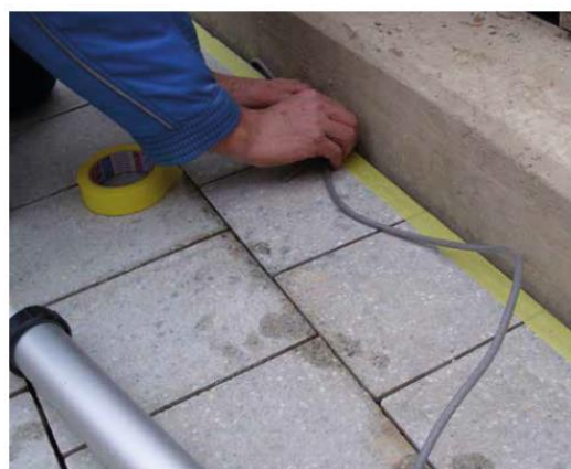
2 Після того, як ґрунтовка випарується, укладіть в шов компенсаційний шнур Sopro PER 567.
