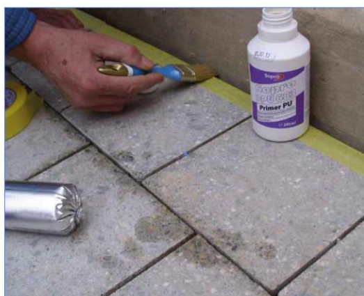
1 Нанесіть ґрунтовку Sopro PPU 683 пензлем на на край, закріплений клейкою стрічкою.
