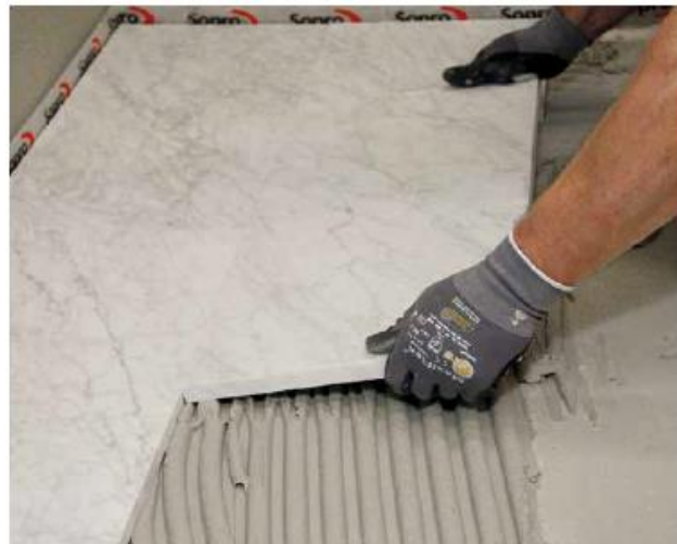
2 Укладання плит з натурального каменю. Завдяки світлому кольору суміщ Sopro FKM® 600 підходить також для укладання світлопрозорих облицювань.
