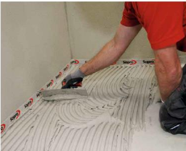
1 Нанесення Sopro FKM® 600 методом середнього шару.
