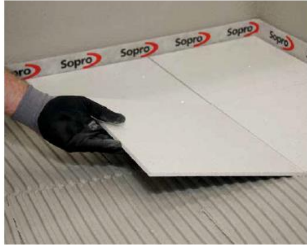
2 Укладання конгломератних плит. Завдяки швидкому схопленню Для укладання також підходить розчин Sopro FKM® 600 чутливе до деформації облицювання.
