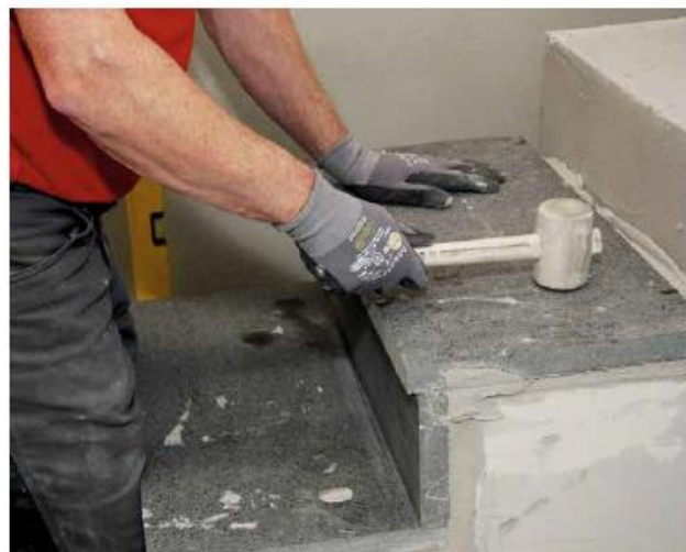
2 Укладання кам'яних сходів. Завдяки швидкому схопленню можливе раннє навантаження на поверхню.
