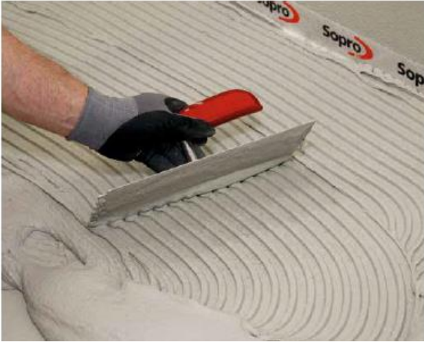
1 Нанесення контактного шару, за яким слідує гребеневий шар напіврідкої консистенції.
